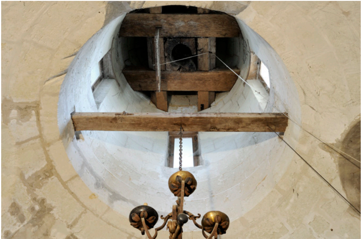
Moulin Neuf (intérieur) : détail des soles et de la huse.
