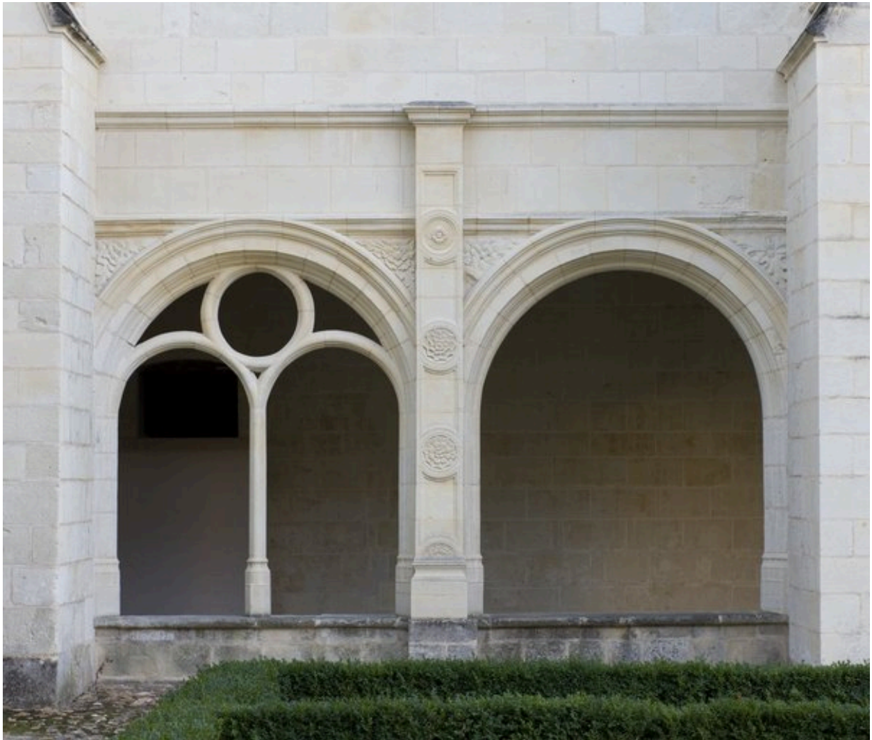
Cloître, galerie sud (vers 1520), un pilastre italianisant et deux arcades (dont l'une conserve son remplage flamboyant) entre deux contreforts.
