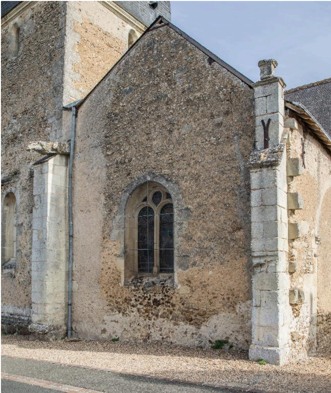
Chapelle sud 2, façade sud.
