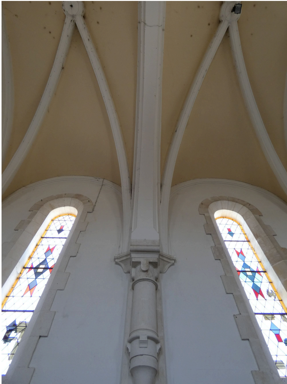
Retombée d'un des arcs doubleaux de la nef.
