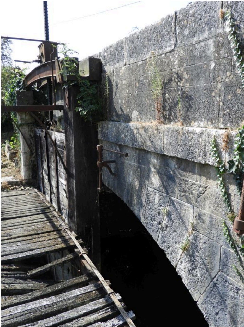
Détail de l'aqueduc, côté amont, depuis le nord-est.
