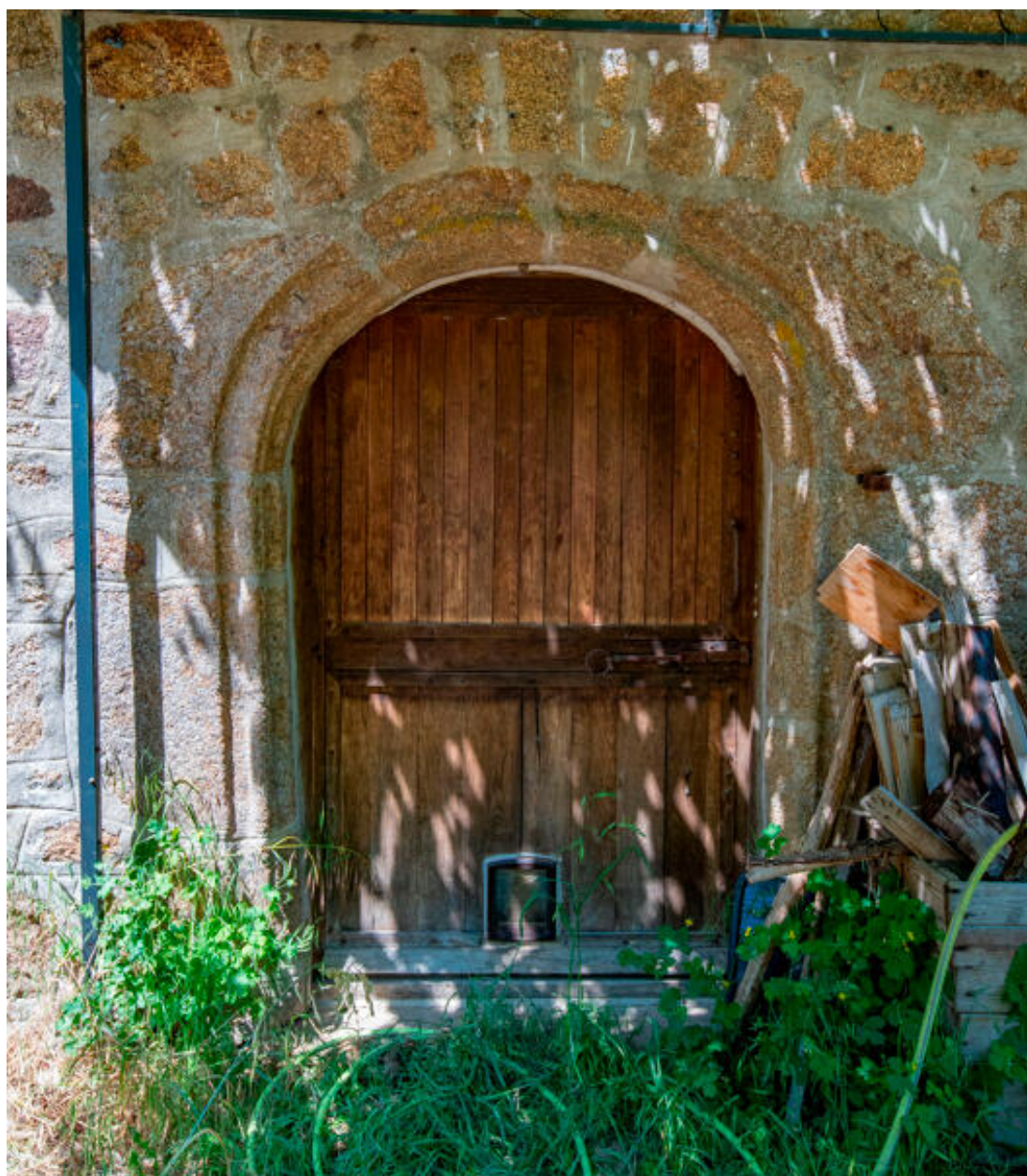
Porte extérieure, milieu de la façade sud (bâtiment 1).
