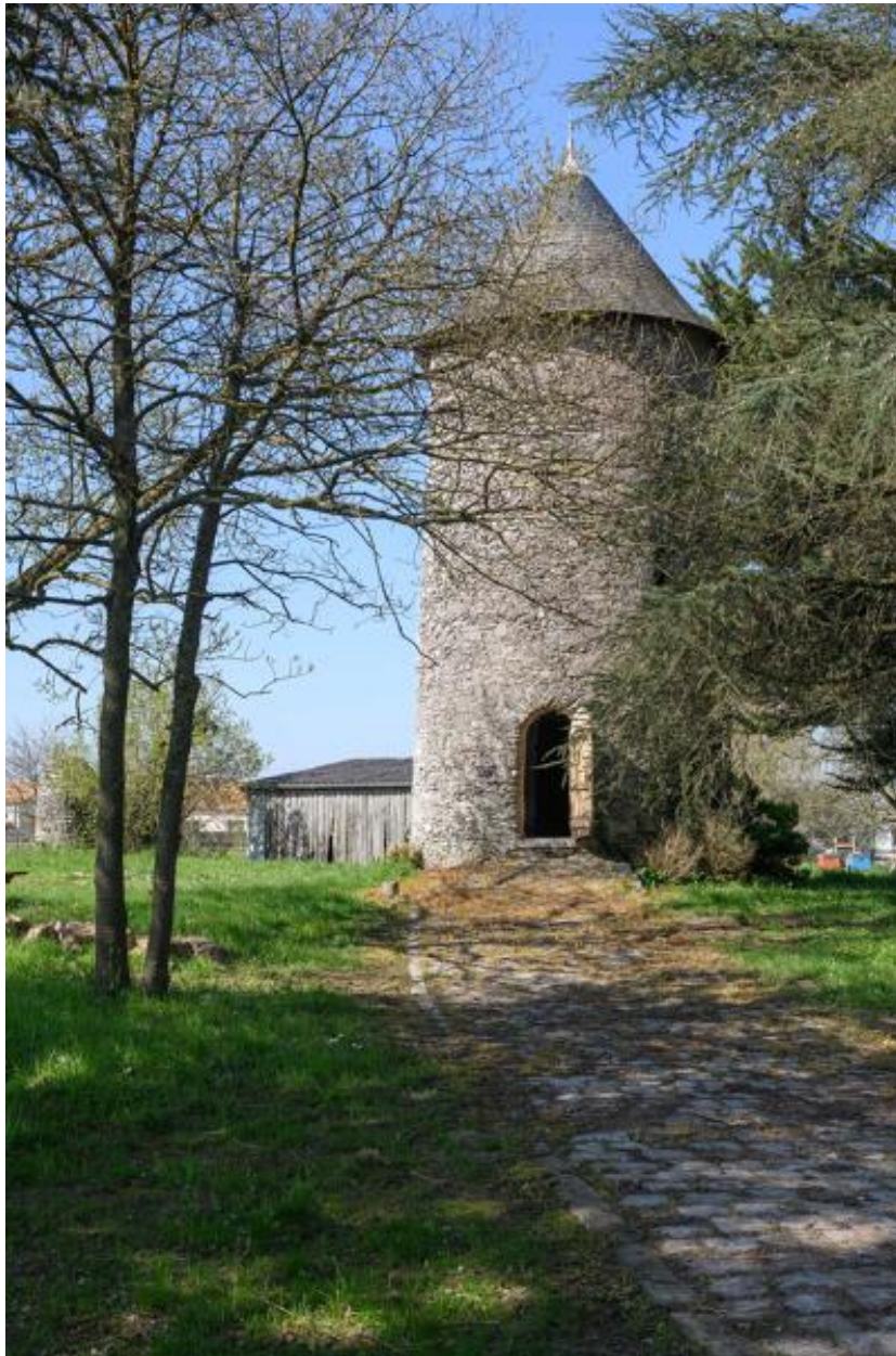
Moulin à farine dit moulin des Buttes (n° 1) ou moulin de l'Ouche-Neuve. Vue d'ensemble depuis le sud.
