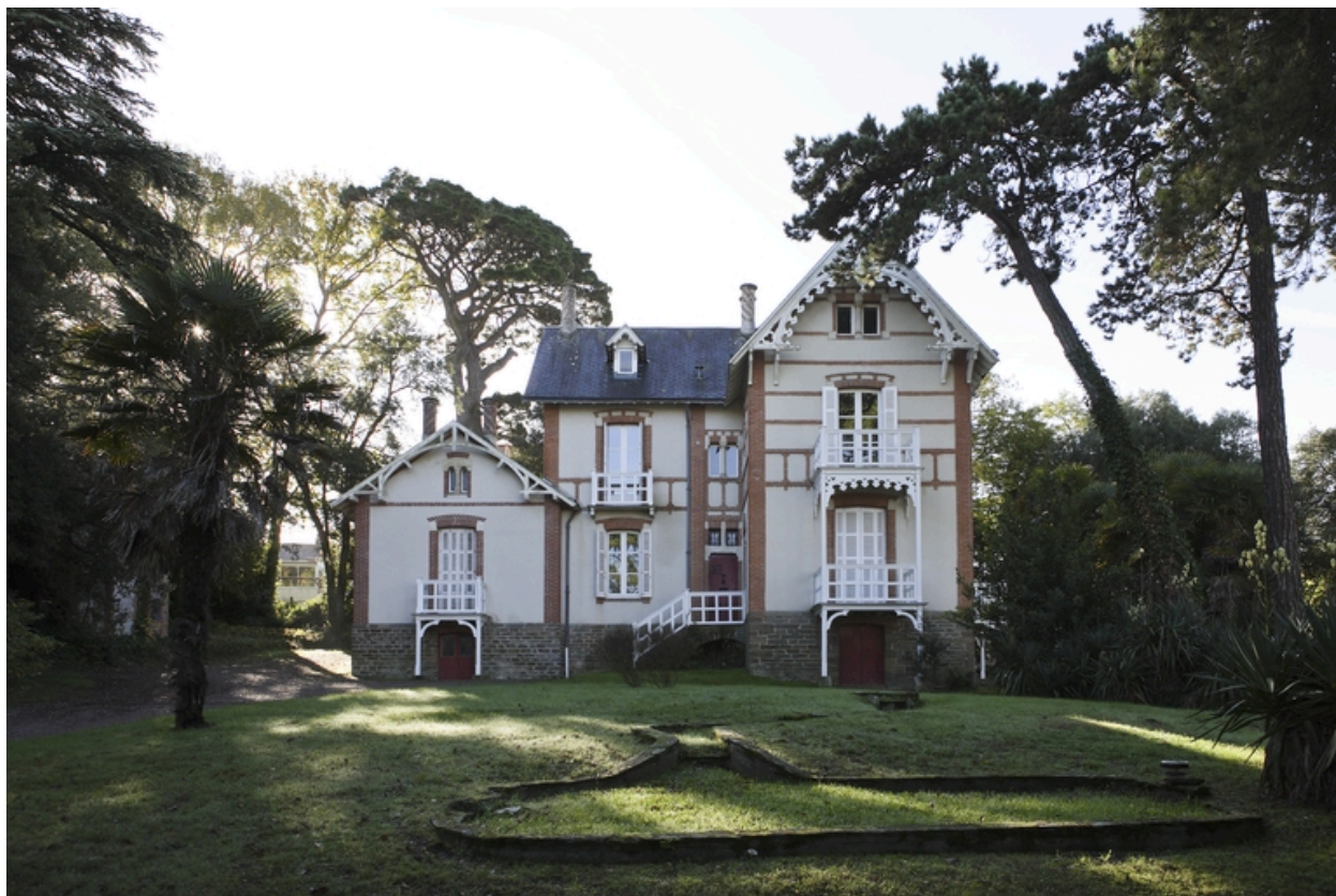
Vue d'ensemble de la villa.
