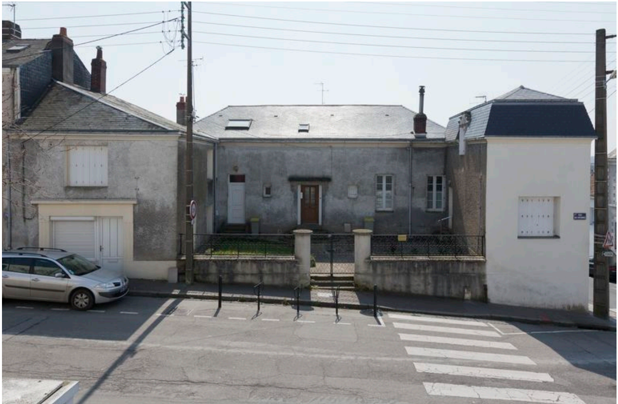
Vue générale de la maison Verne.
