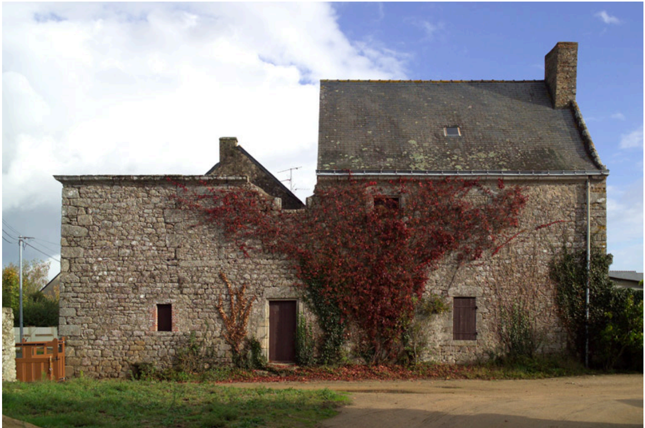
Aile sud, élévation sud.
