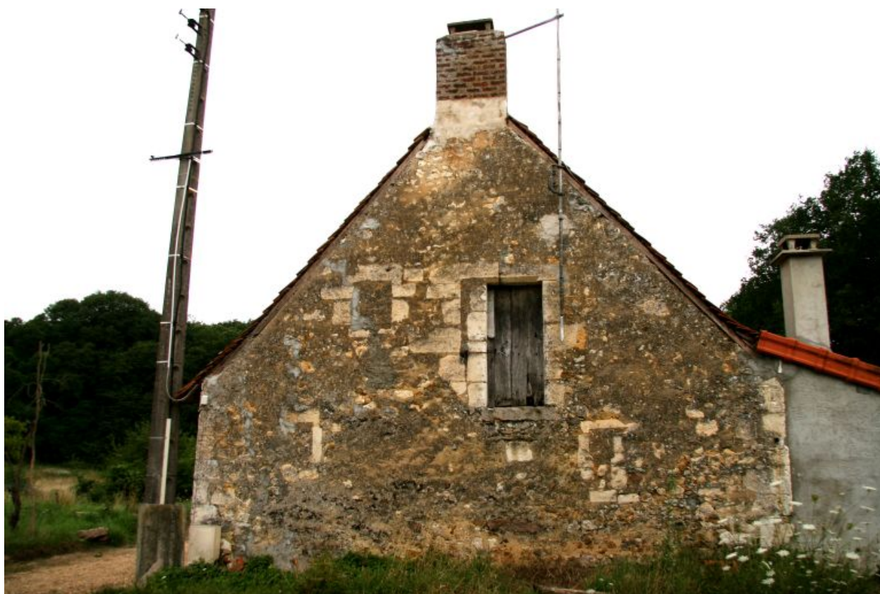
Maison de potier : pignon.
