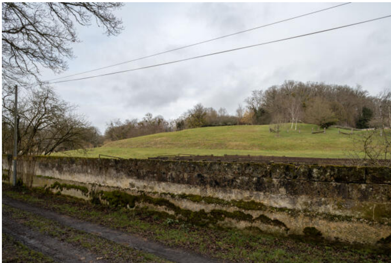
Mur de clôture, vu depuis le sud.
