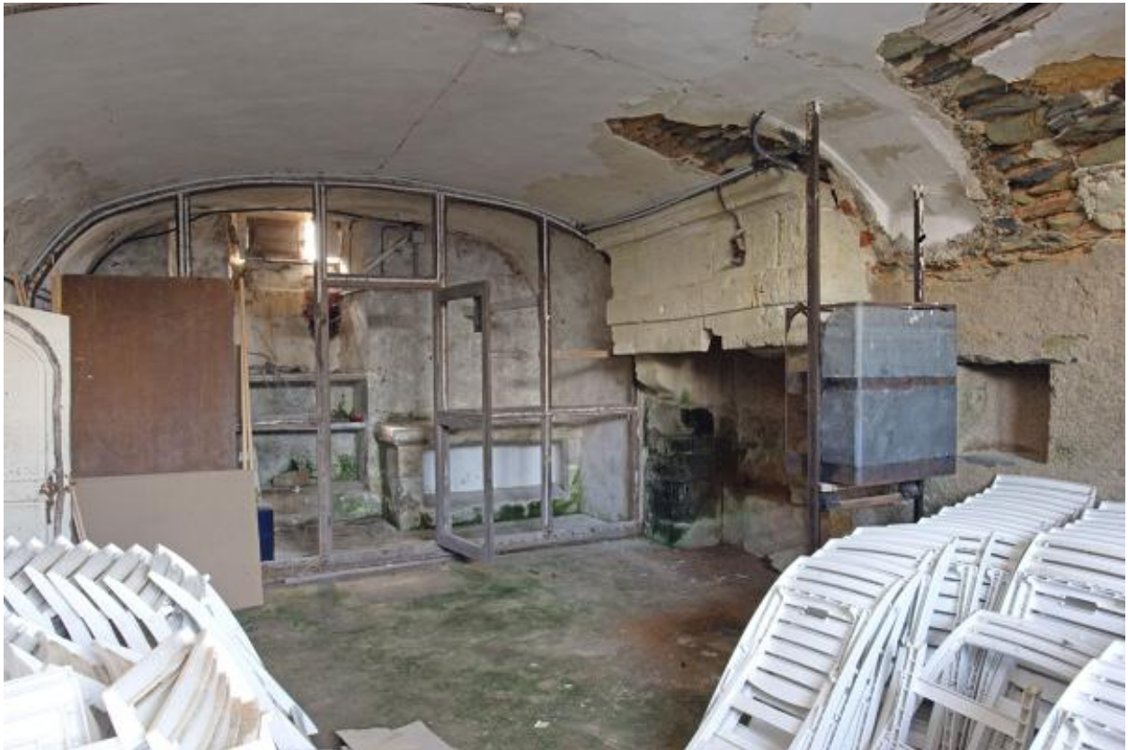
Une pièce du sous-sol.
