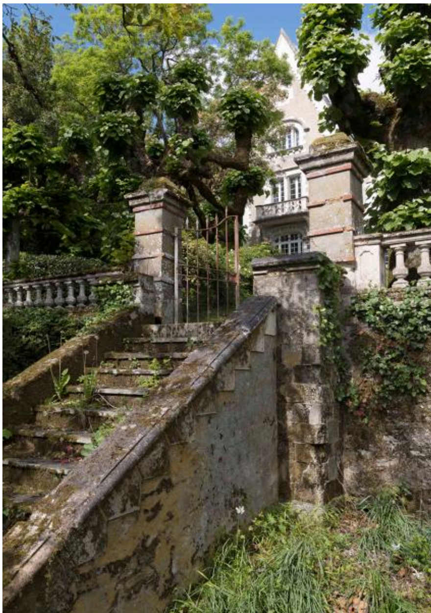
Détail de l'escalier droit en pierre permettant l'accès à la voie de chemin de fer.
