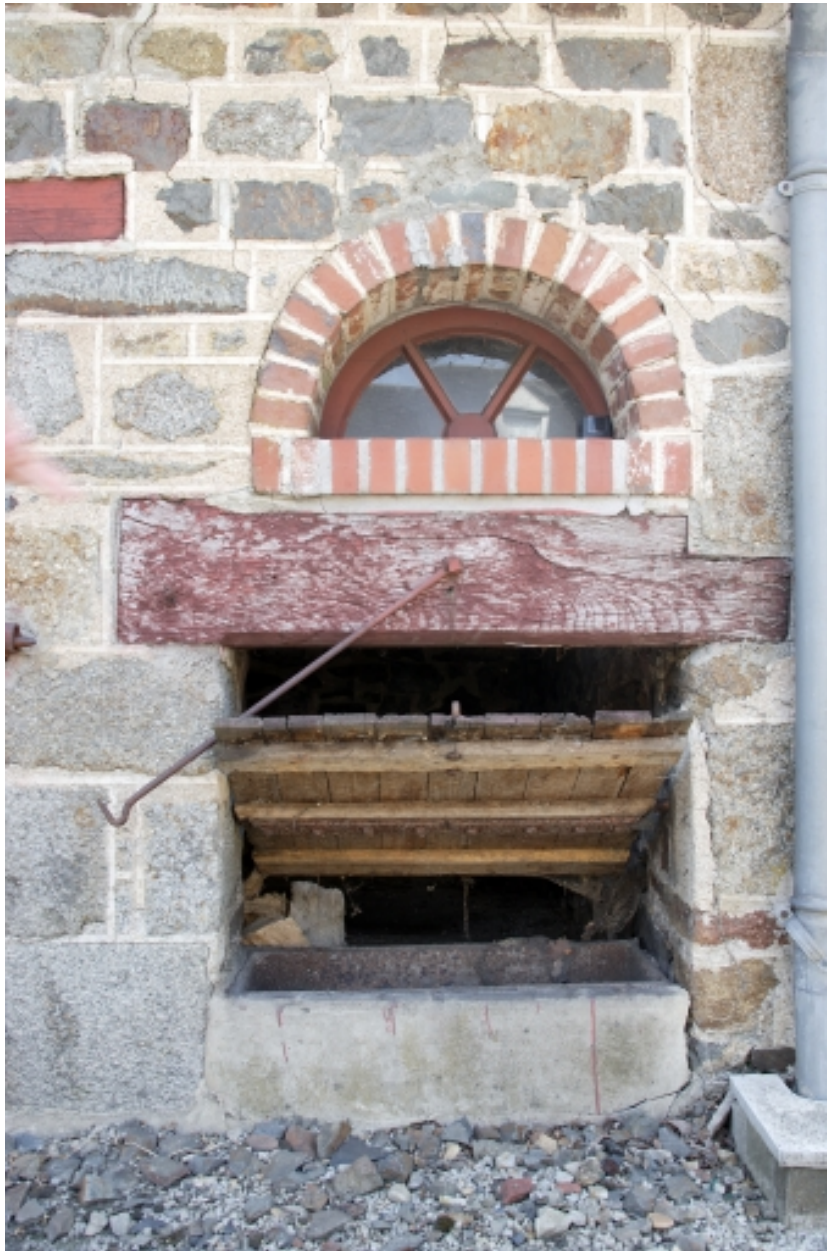
Ouverture d'alimentation de la nouvelle porcherie.
