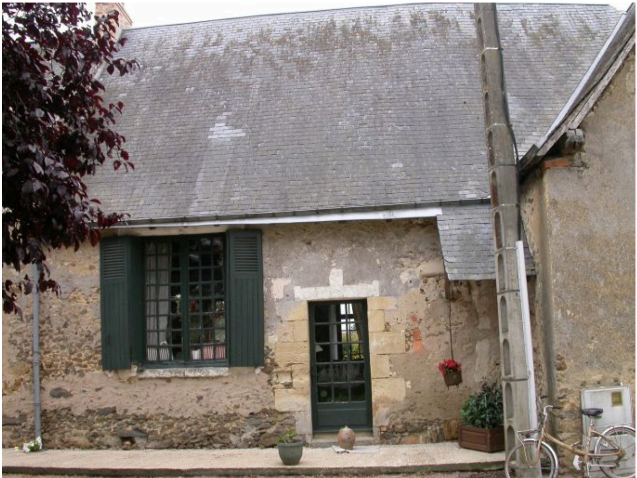
Façade antérieure sur cour.
