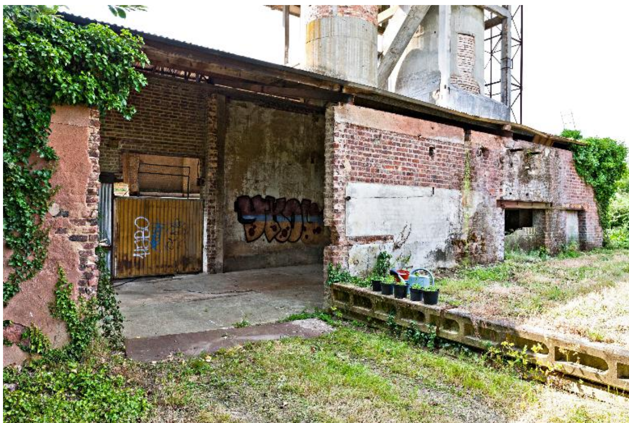
Espace de stockage à l'avant des fours à chaux.
