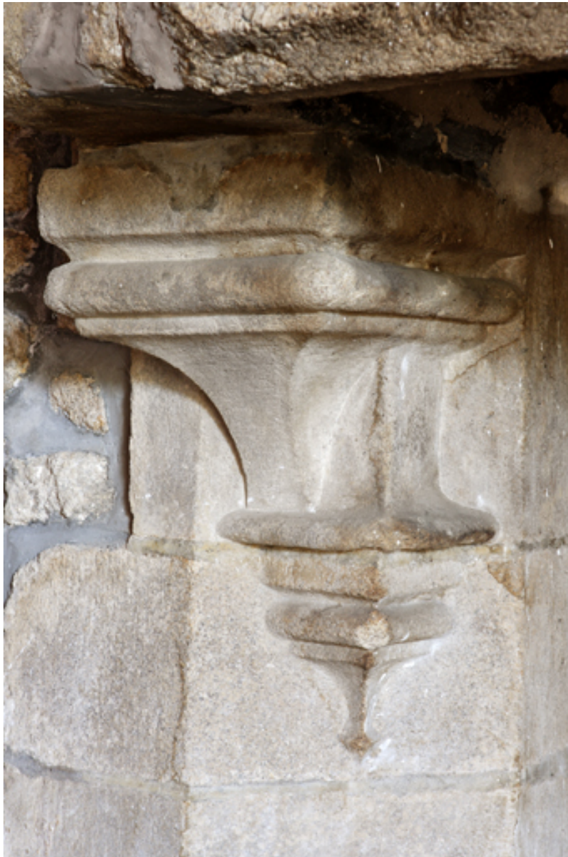
Logis. Rez-de-chaussée. Salle nord. Détail du corbeau de gauche de la cheminée.
