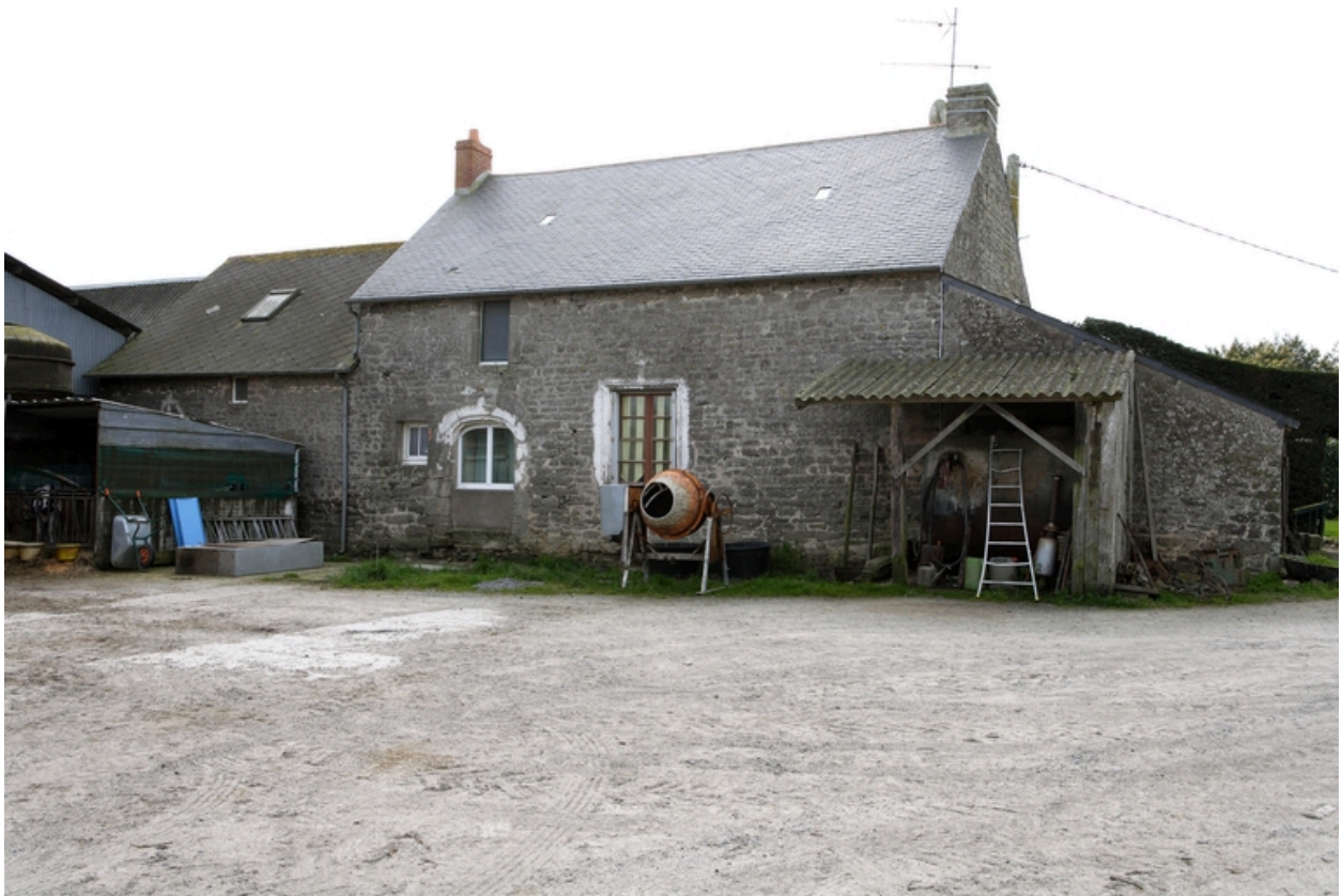
Vue de la façade nord du logis.
