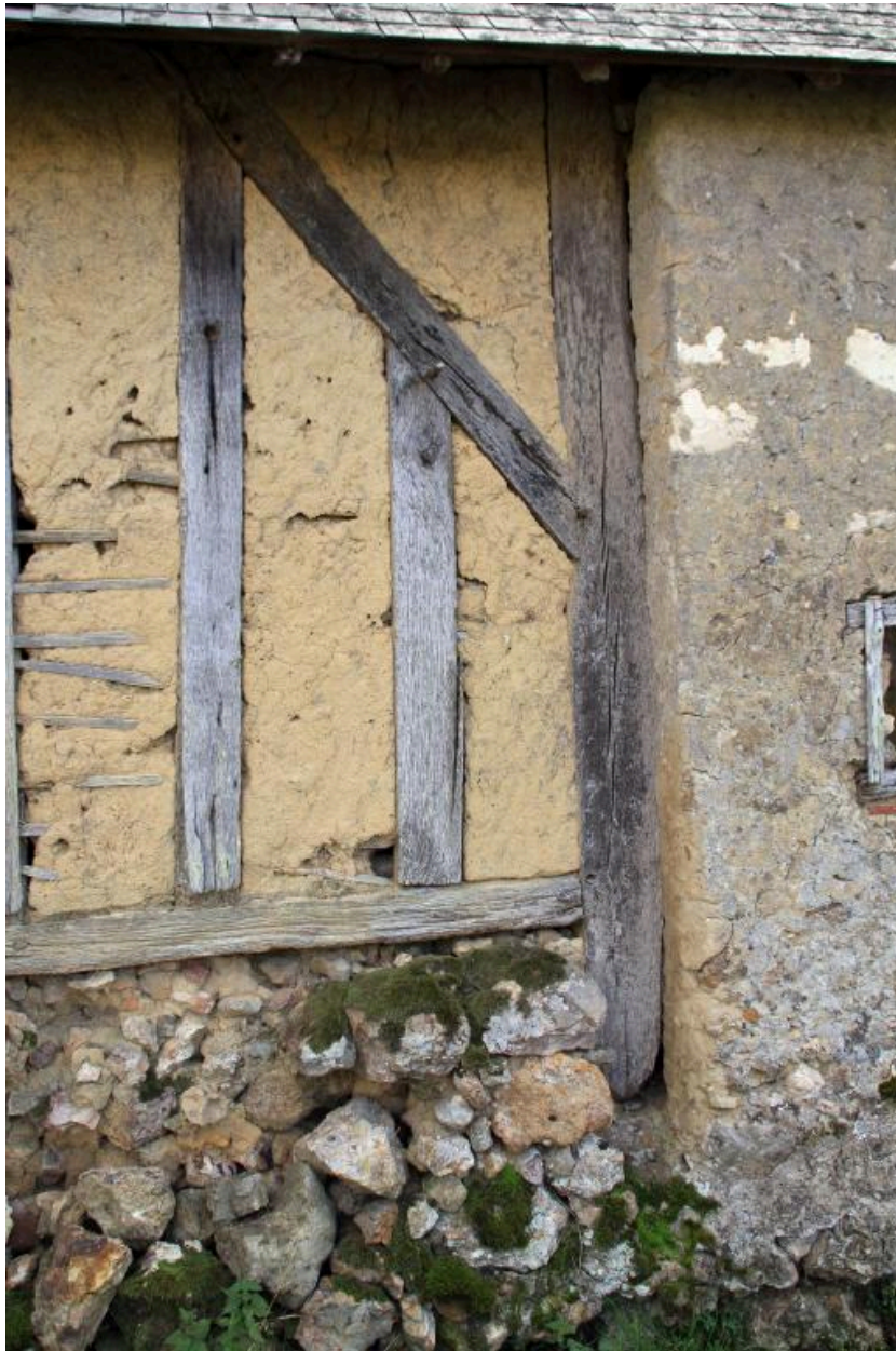
Grange en pan de bois : poteau cornier et remplissage de torchis.
