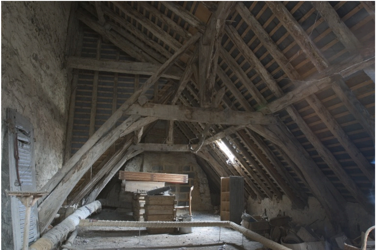
Comble du corps de bâtiment de l'ancienne cuisine : la charpente vue depuis l'est.
