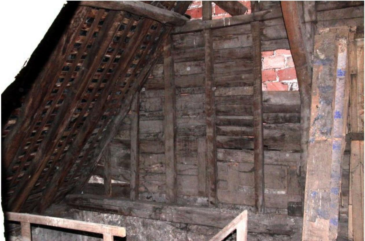
Comble : cloison en planches.
