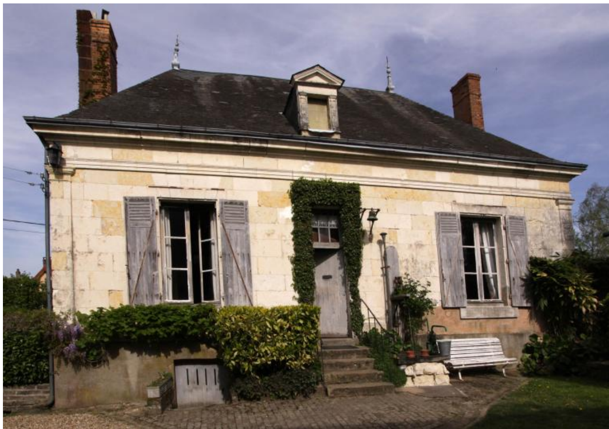
Maison : façade sur cour.
