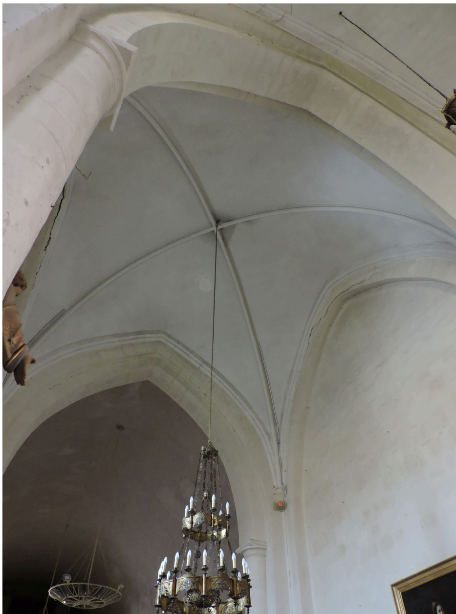
La voûte de la première travée du chœur.
