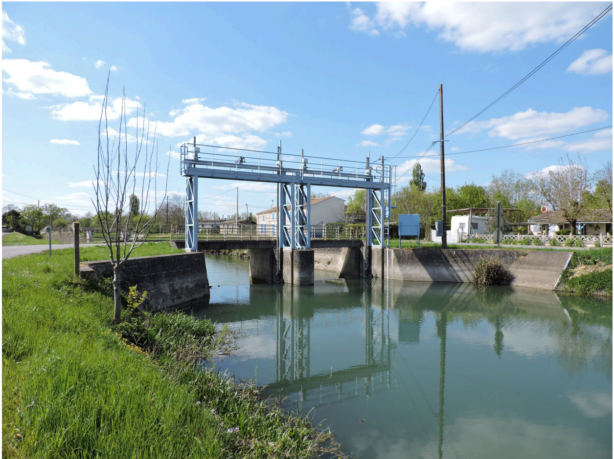
Le barrage vu depuis l'amont, au sud.
