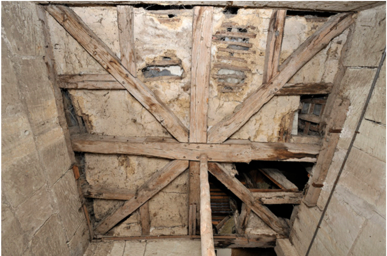
Vue de la charpente de la tourelle d'escalier
