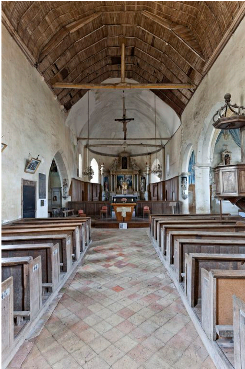
Vue intérieure depuis la nef.
