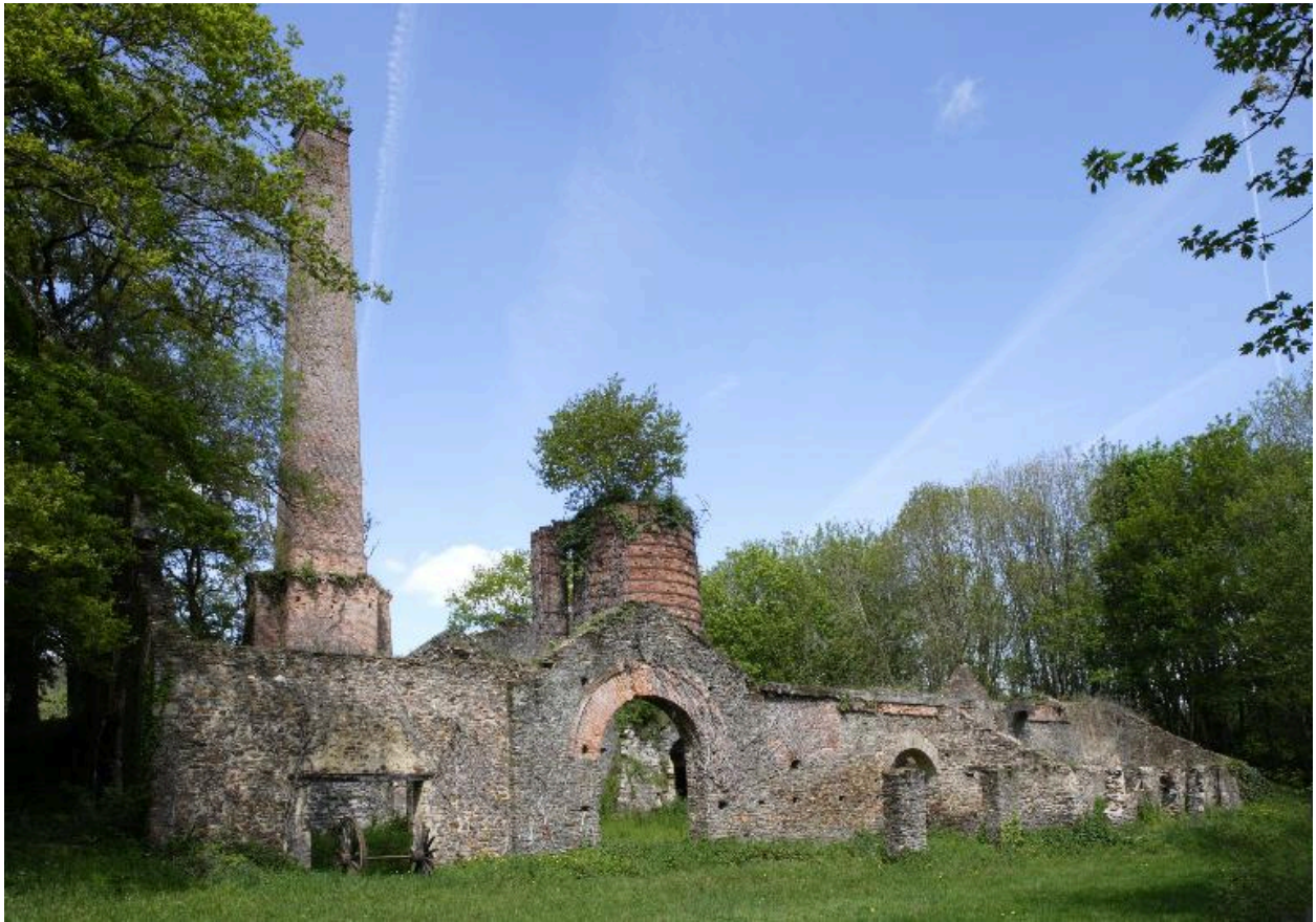
Halle de coulée.
