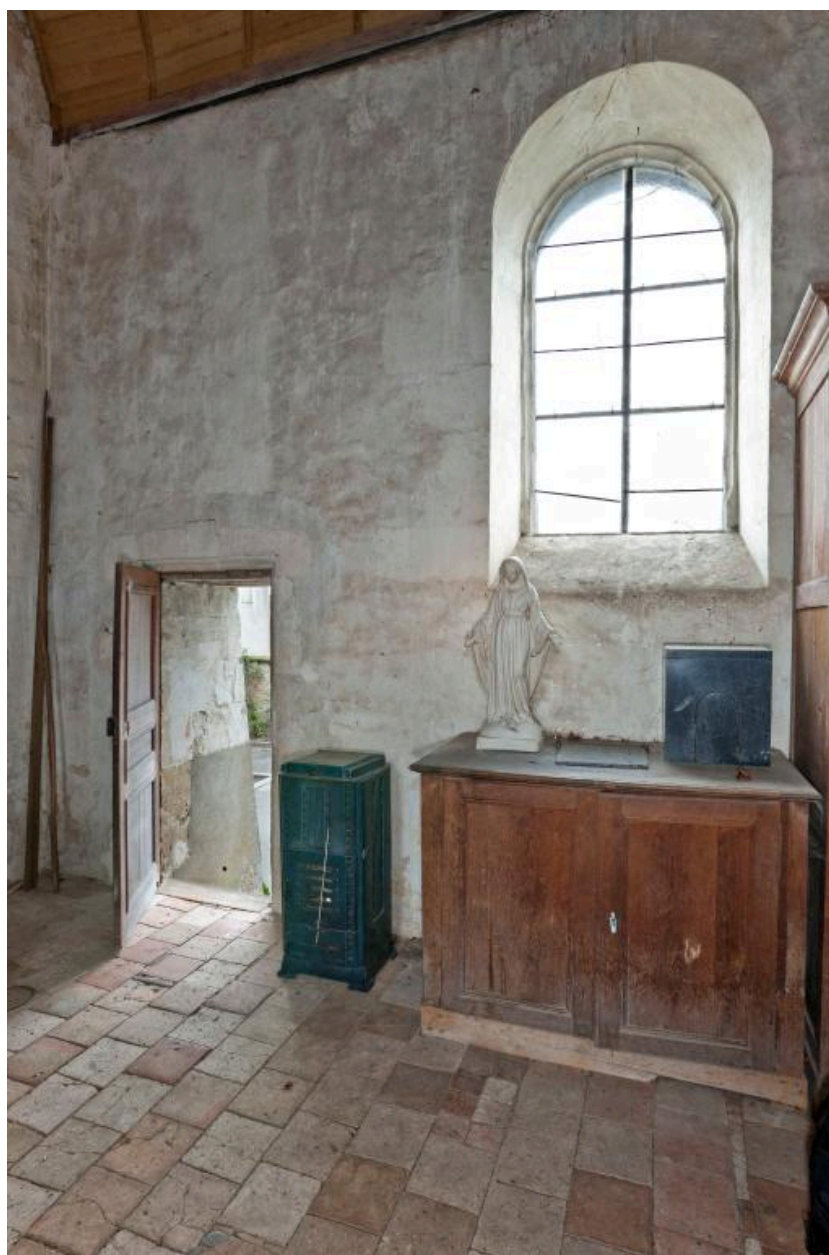
Sacristie. Porte ouvrant sur le mur est.
