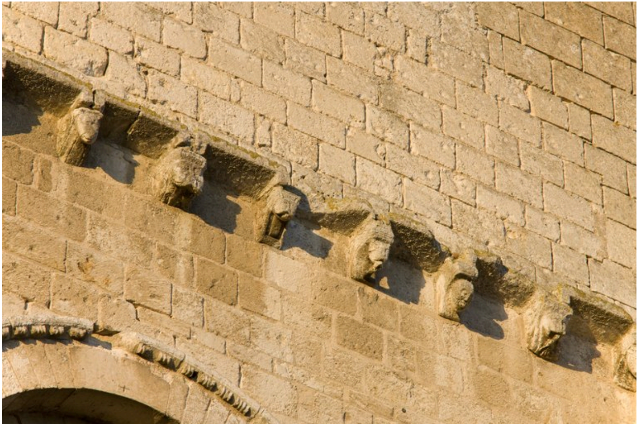
Façade du bras nord du transept : partie droite de la frise de modillons.
