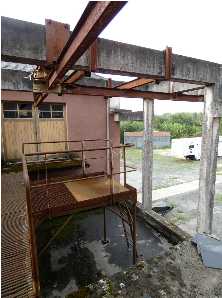
Le portique à l'extrémité ouest du bâtiment des chambres froides, vu depuis le nord.
