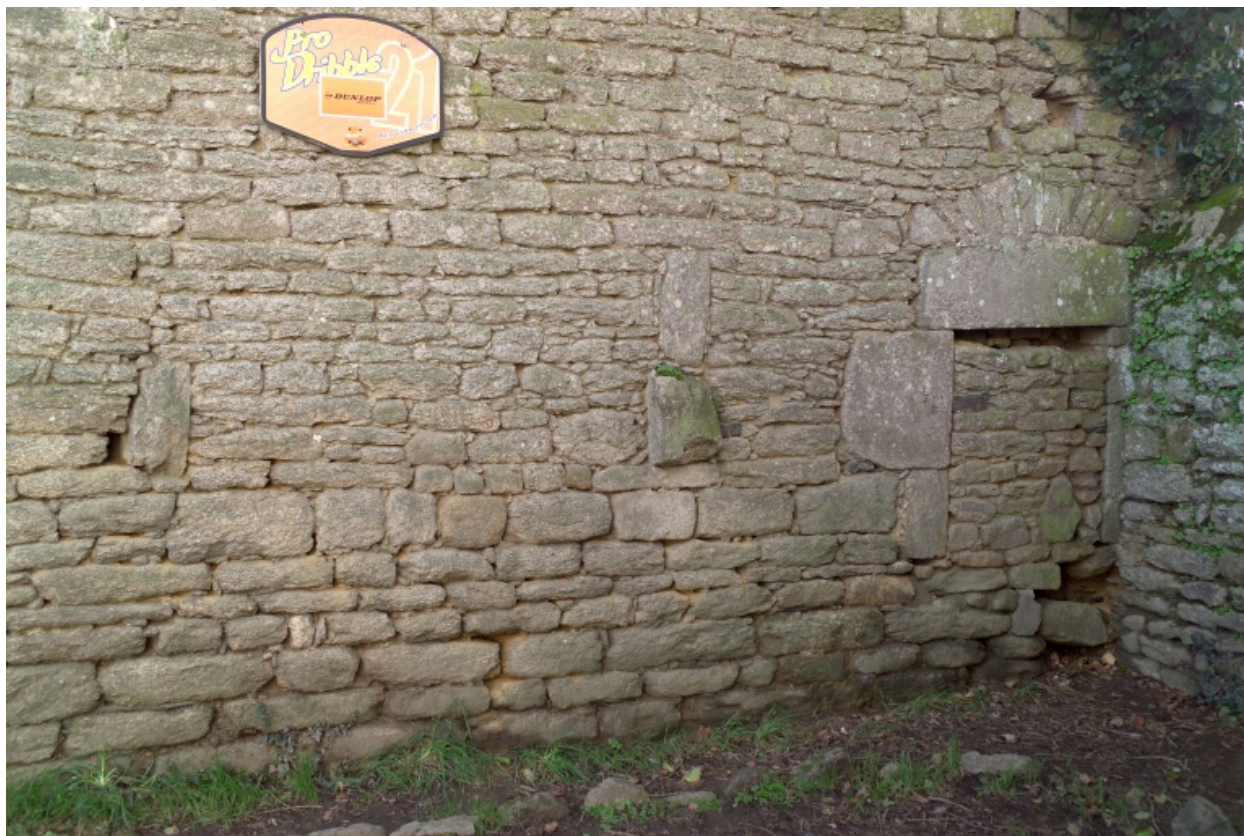
Bâtiment ouest. Détail du pignon nord.
