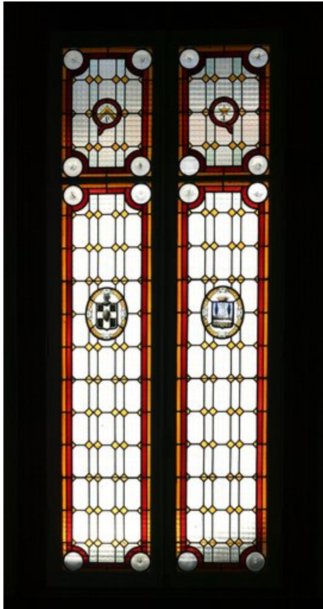
Vue d'ensemble de la verrière du mur ouest de la cage d'escalier.
