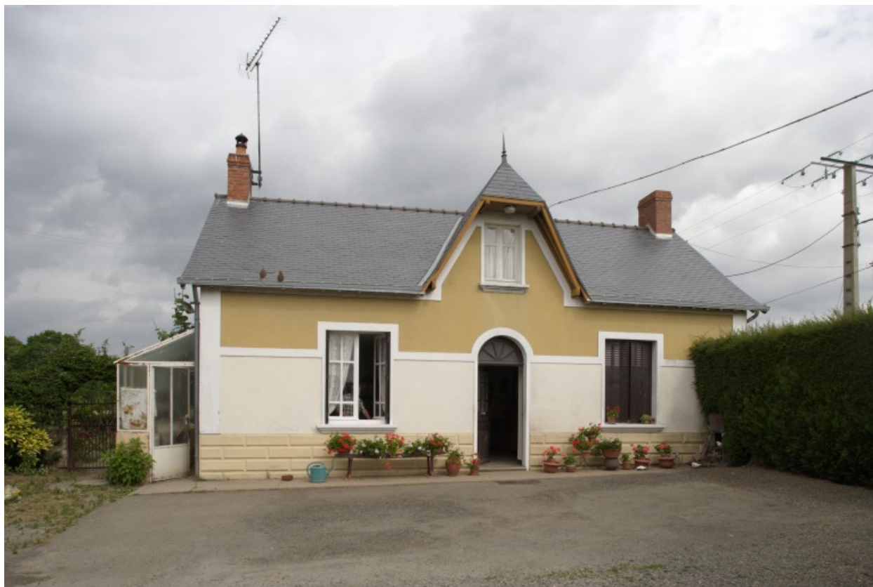
Le logis vu depuis l'est.
