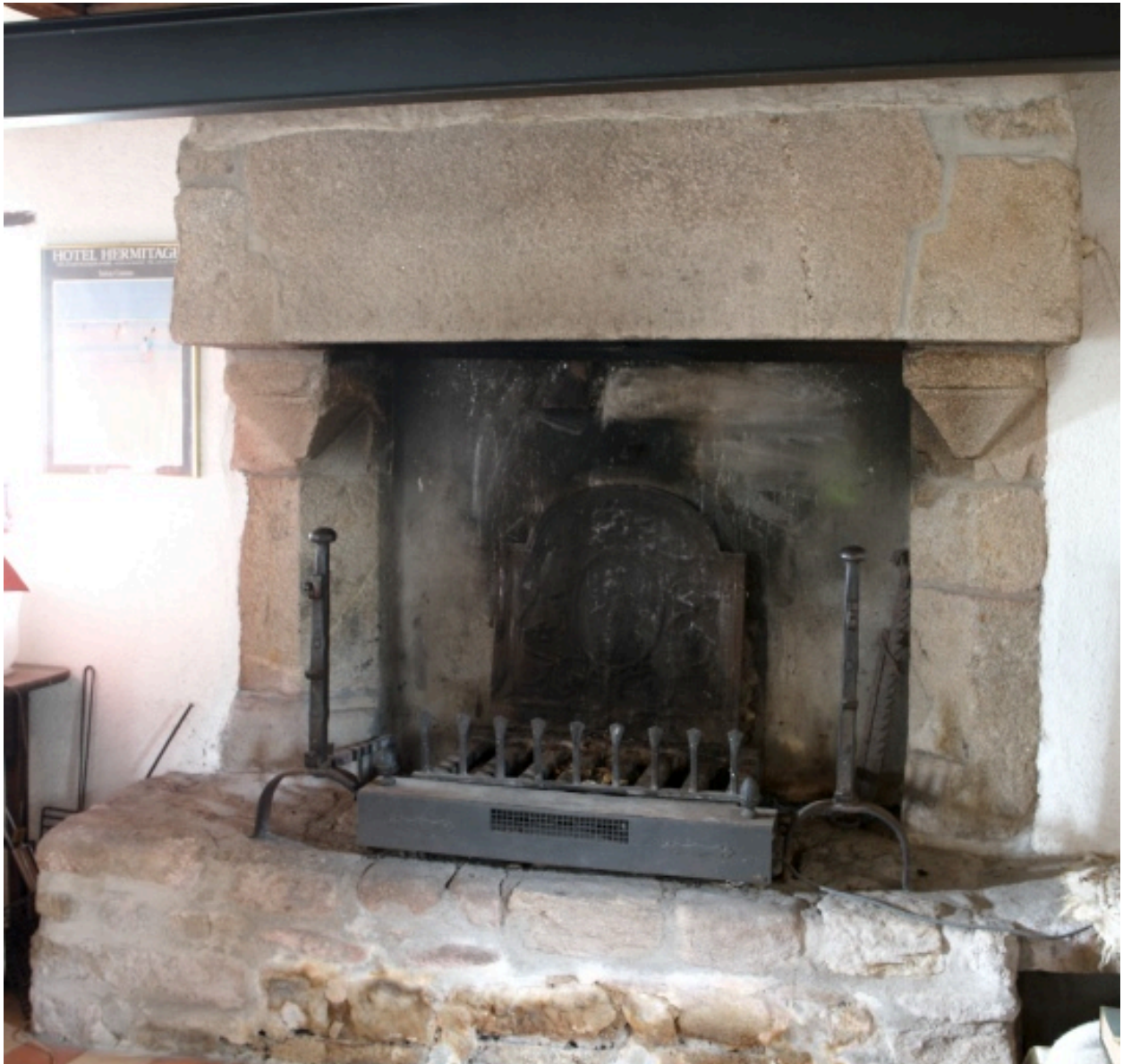
Vue de la cheminée du rez-de-chaussée du logis ouest.
