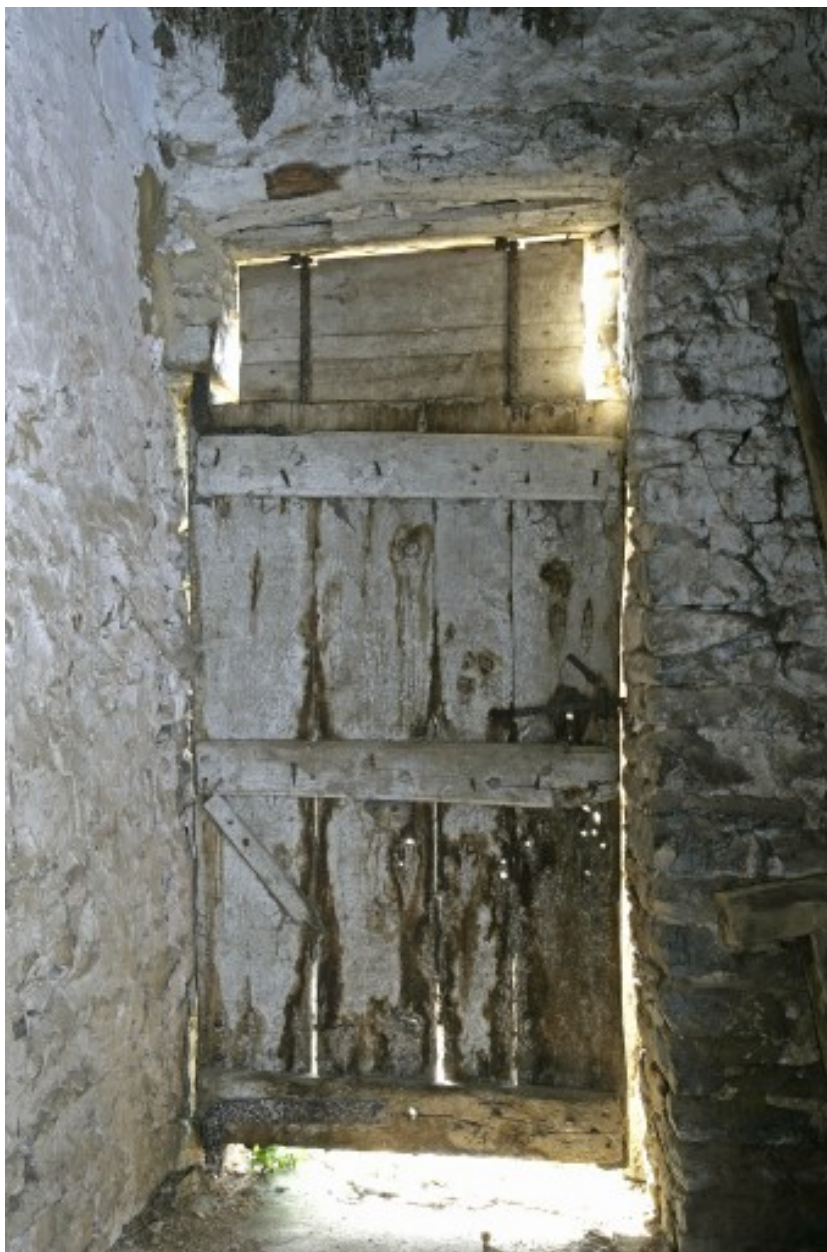
Grange-étable : la face intérieure de la porte ouest de l'appentis sud.
