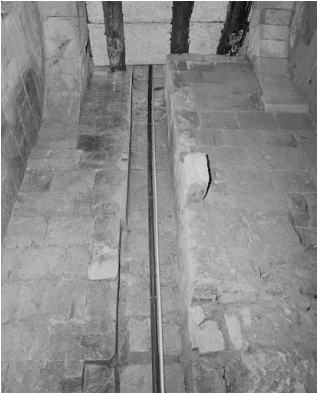
Sous-sol, système hydraulique, puits central des latrines (?).
