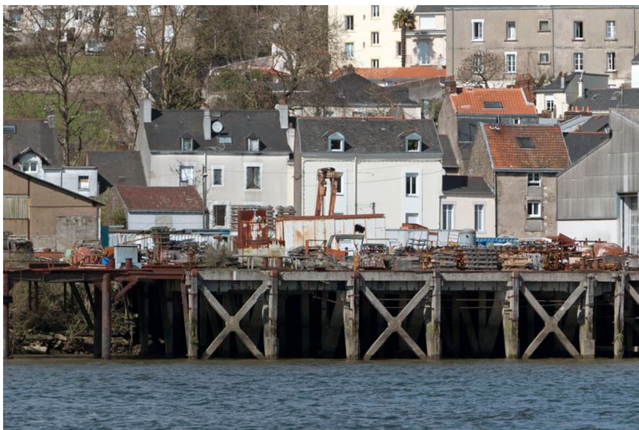
Façades, rue des Chantiers Crucy.
