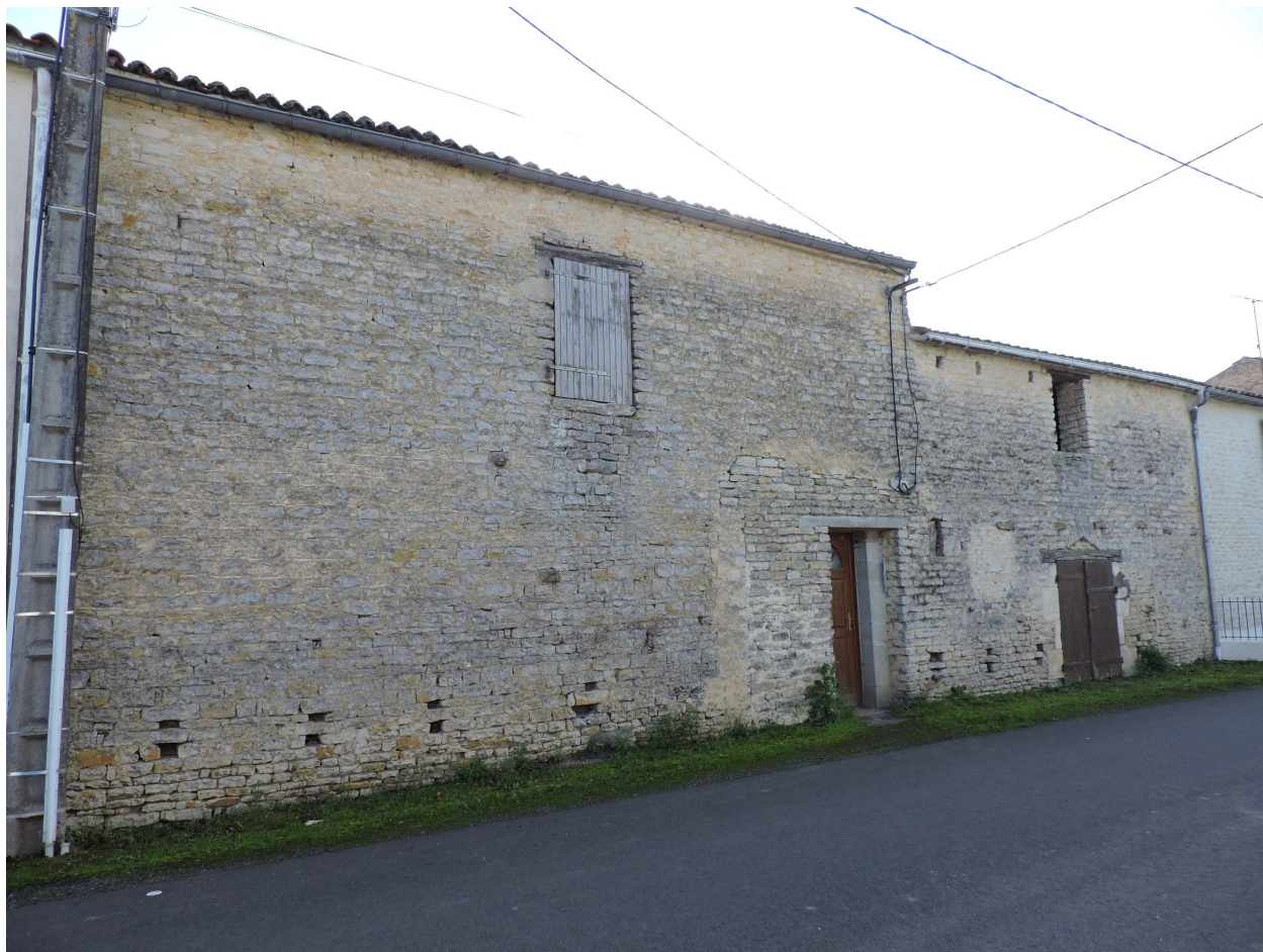
Les dépendances dans le prolongement du logis, vues depuis le nord-est.
