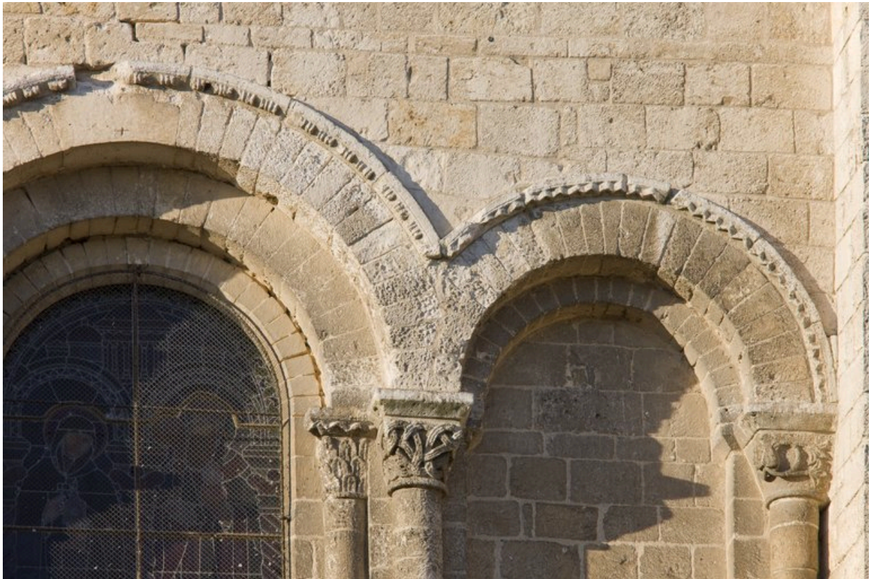
Façade du bras nord du transept : partie droite du niveau supérieur.
