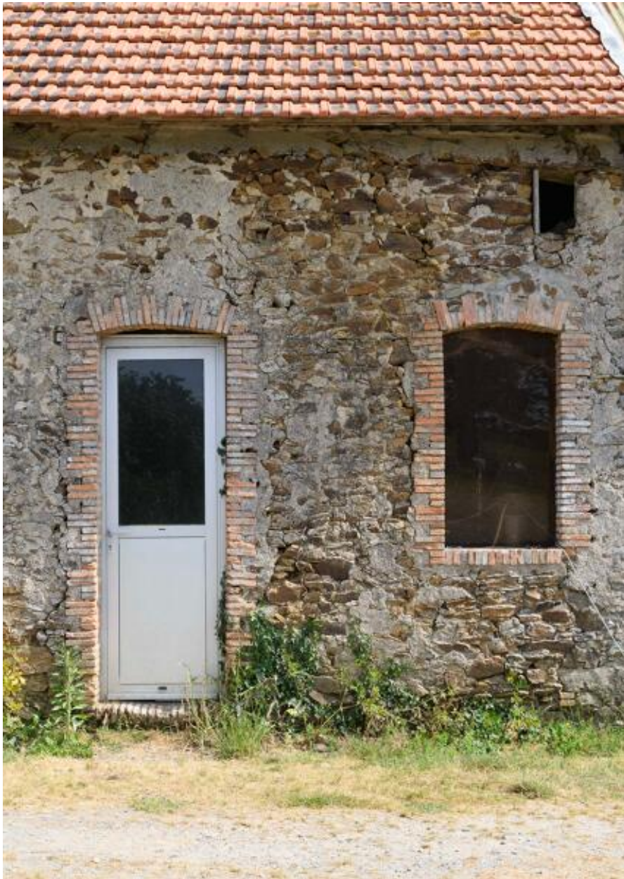
Détail des encadrement en briques d'un des logis du Plessis Pasquier.
