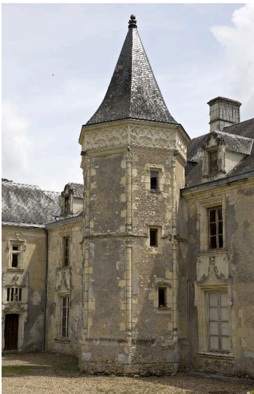
Élévation nord : la tour logeant l'escalier en vis.
