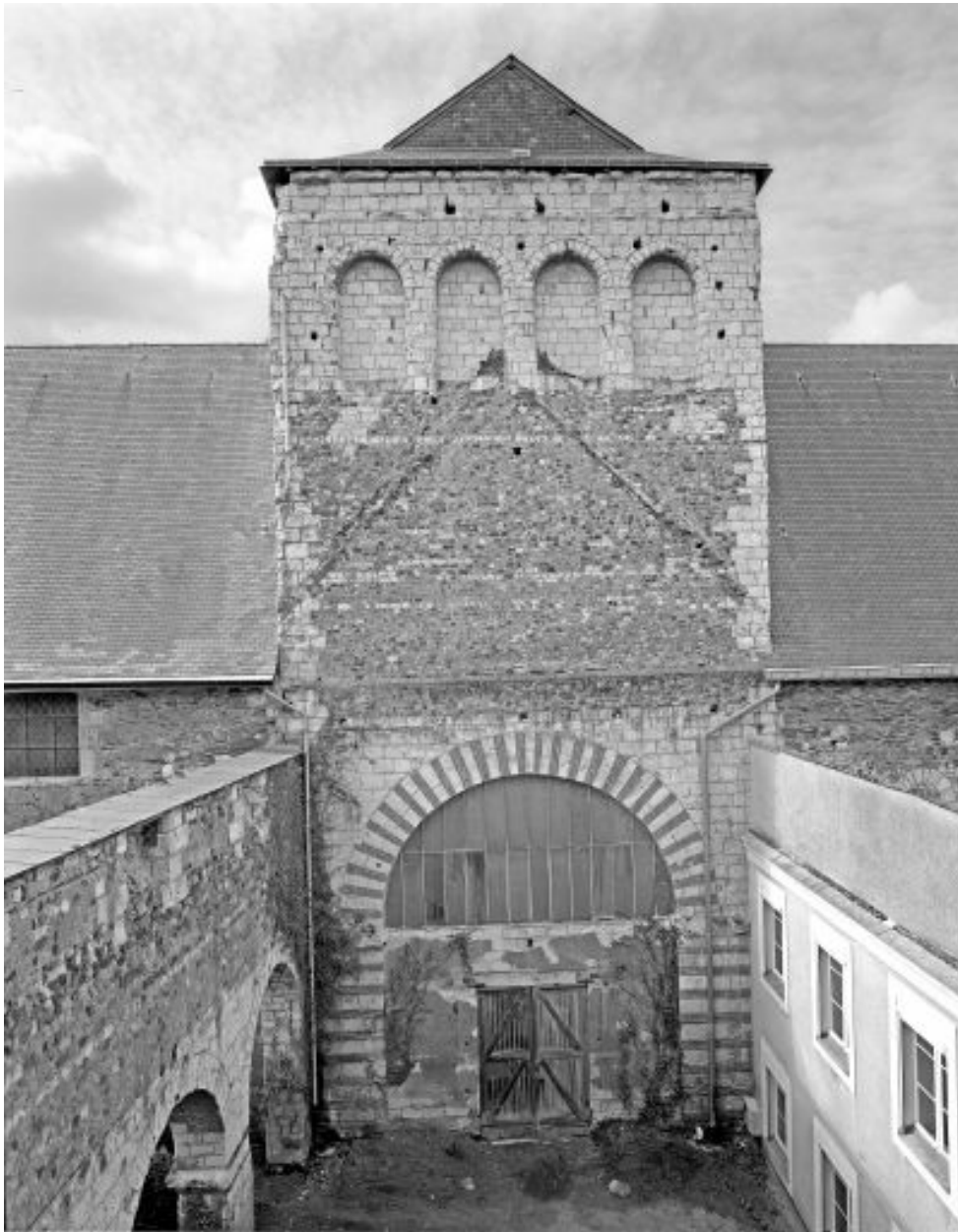
Vue plongeante de la nef et de la tour de croisée du transept.
