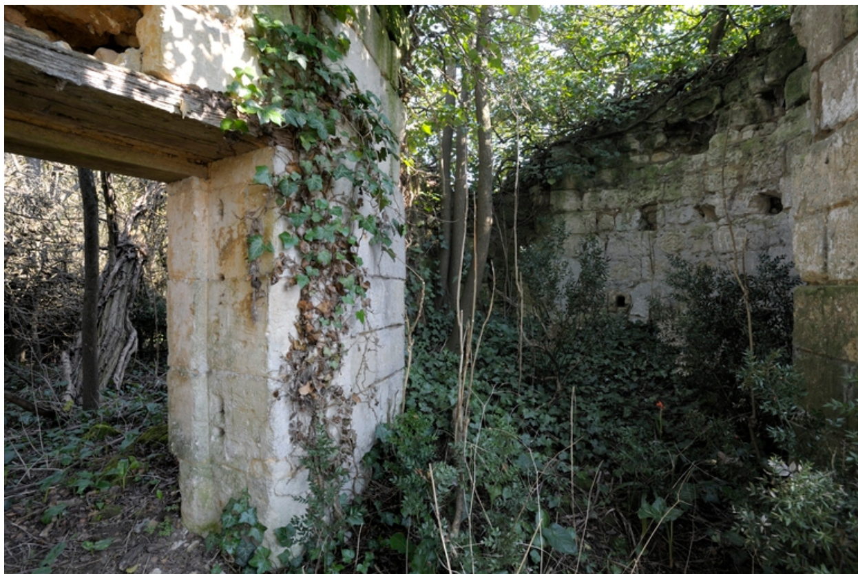
Clôture : tourelle d'angle nord-est du mur de la clôture de Saint-Jean-de-l'Habit (2).
