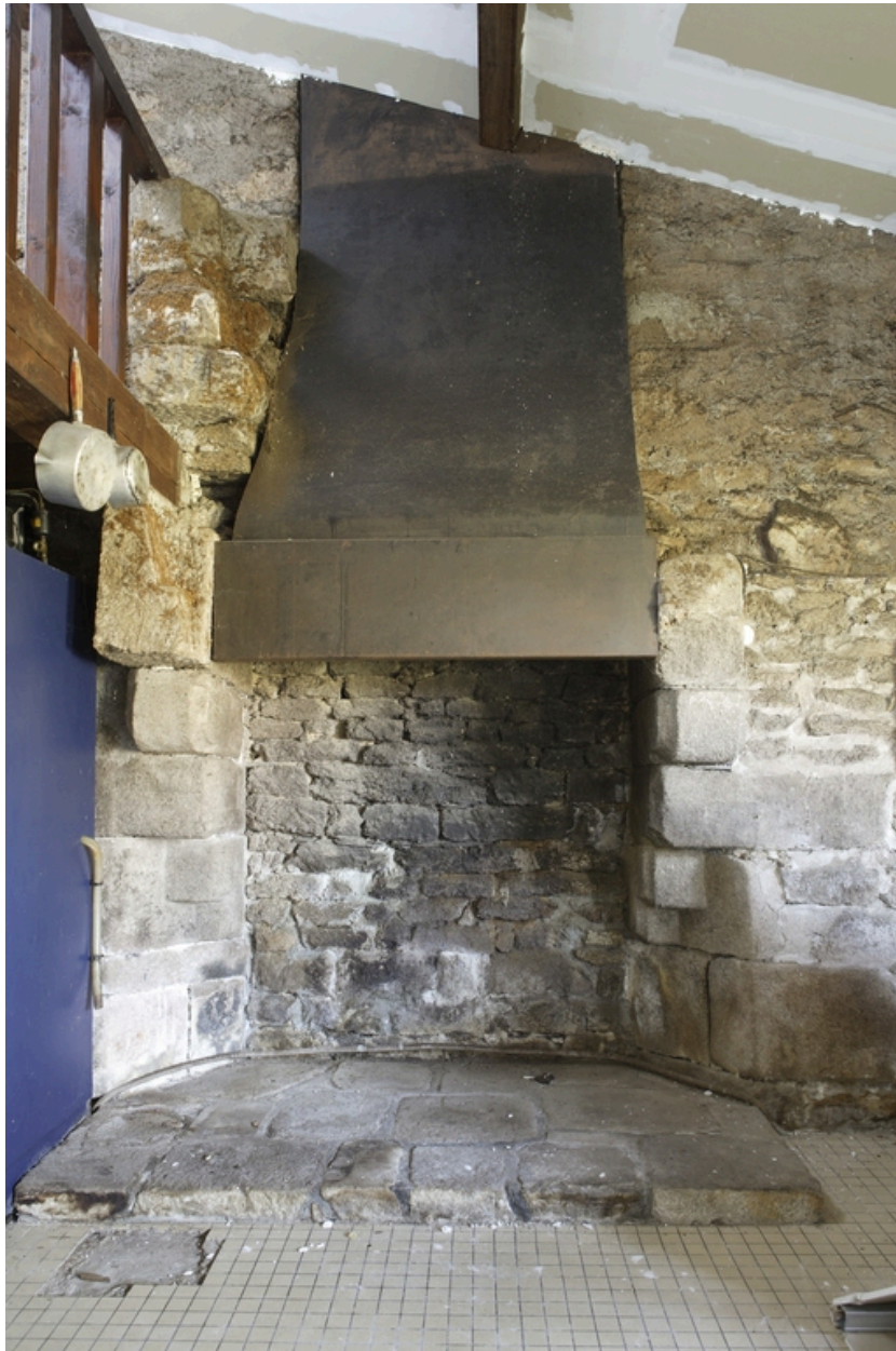
Aile est. Salle nord. Vue de la cheminée.
