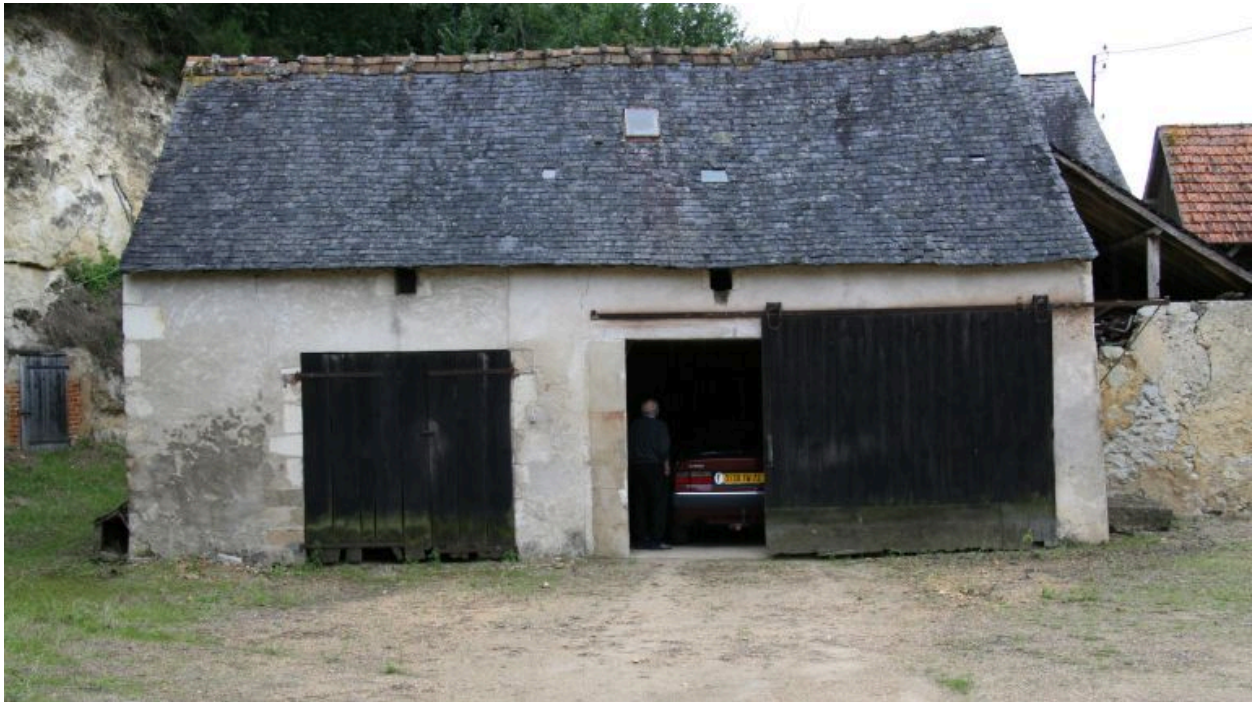
Deuxième maison transformée en étable : façade sur cour.
