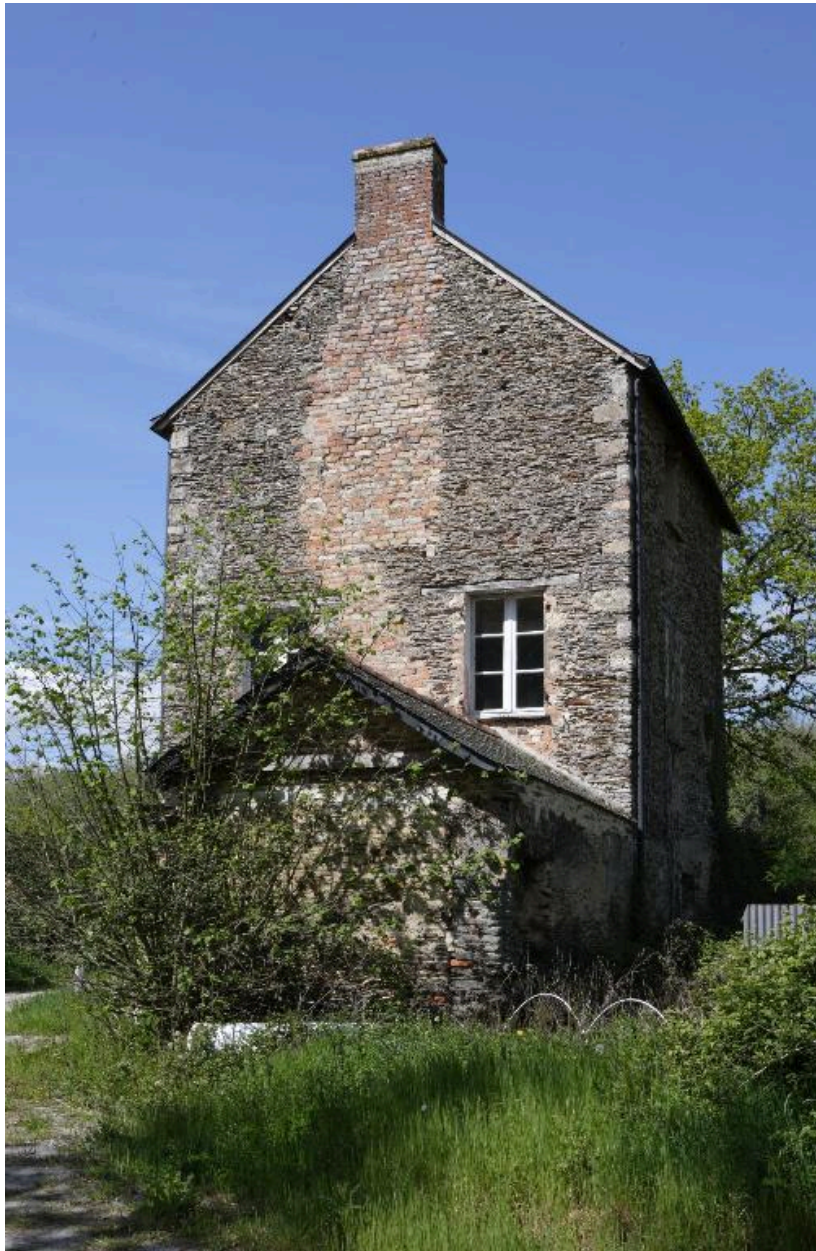
Ancienne maison du garde.
