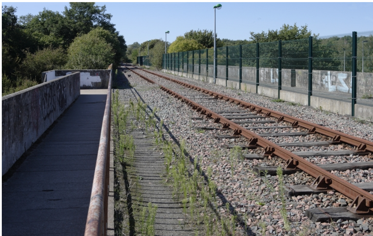
Voies piétonne et ferrée (direction Châteaubriant).
