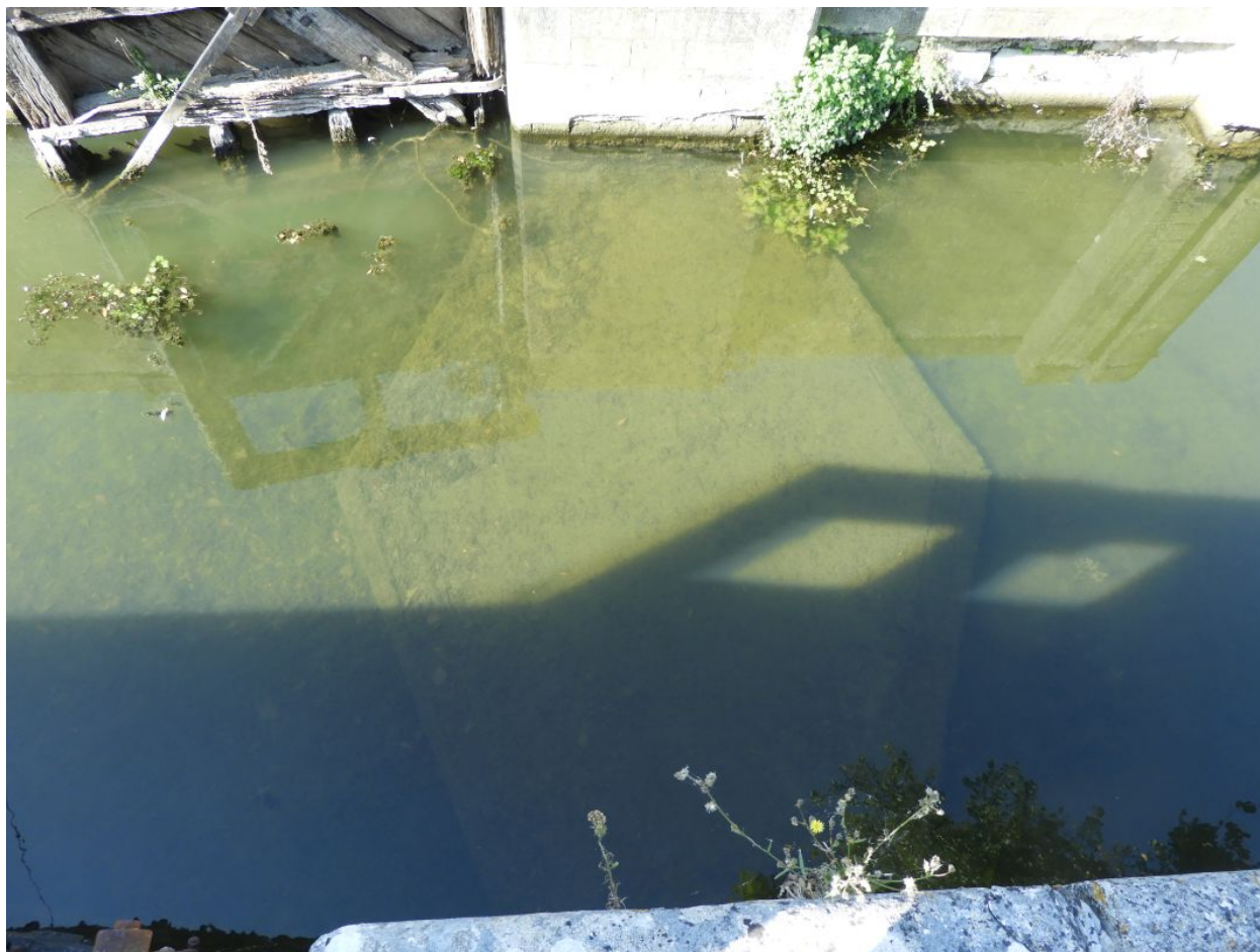
Le radier busqué des portes de tête amont de l'écluse.
