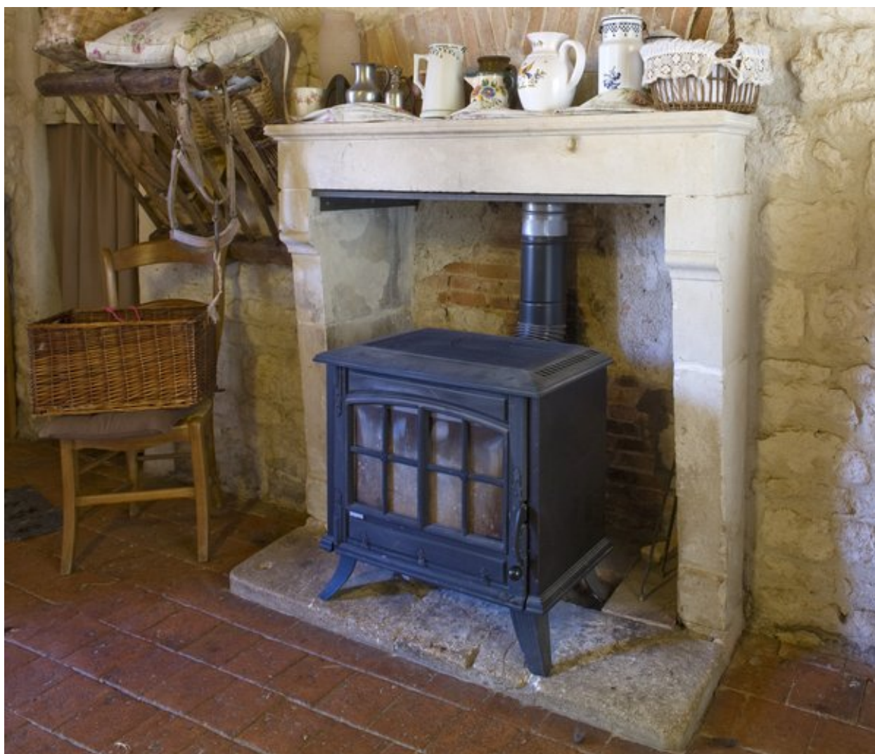
Cheminée de la pièce au nord de la cuisine.
